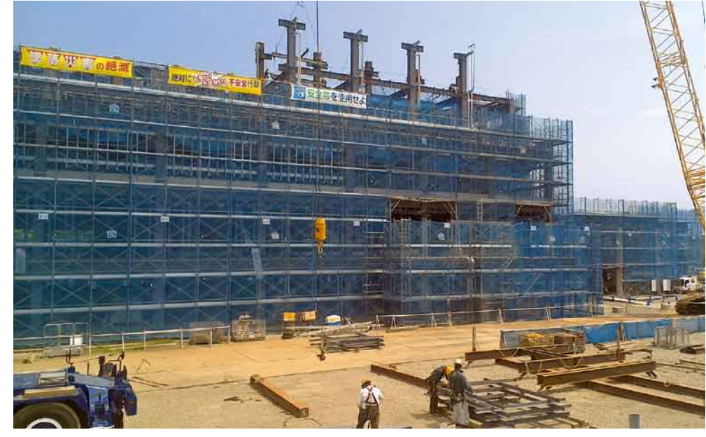
鉄骨建方は7階の床まで進行中
